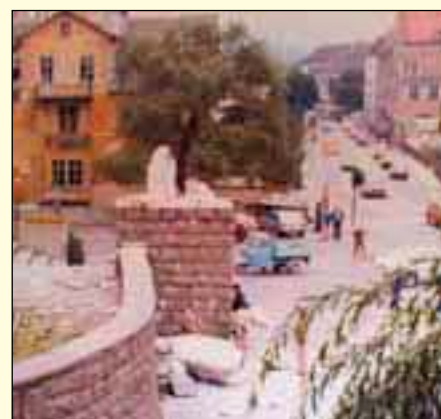
Lavori di costruzione del Monumento
